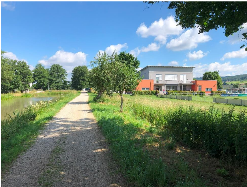
Abschnitt südlich des Plangebiets mit bestehendem Sportplatz und Funktionsgebäude der Sportanlage
