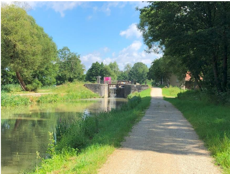
Schleuse 25 , gut 800 m südlich des Plangebiets
